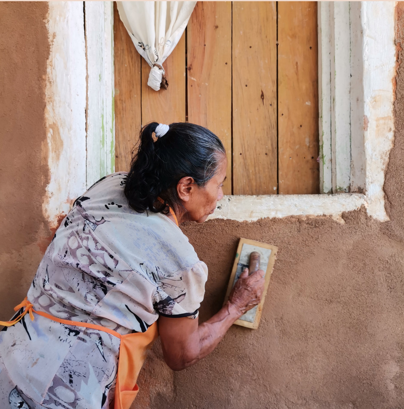
Nori Mendéz, FSAR (2022). Lastenia Montes realizando un trabajo de repello, taller de mejoramiento de vivienda. Silén Moradel, Trujillo, Colón, Honduras.
