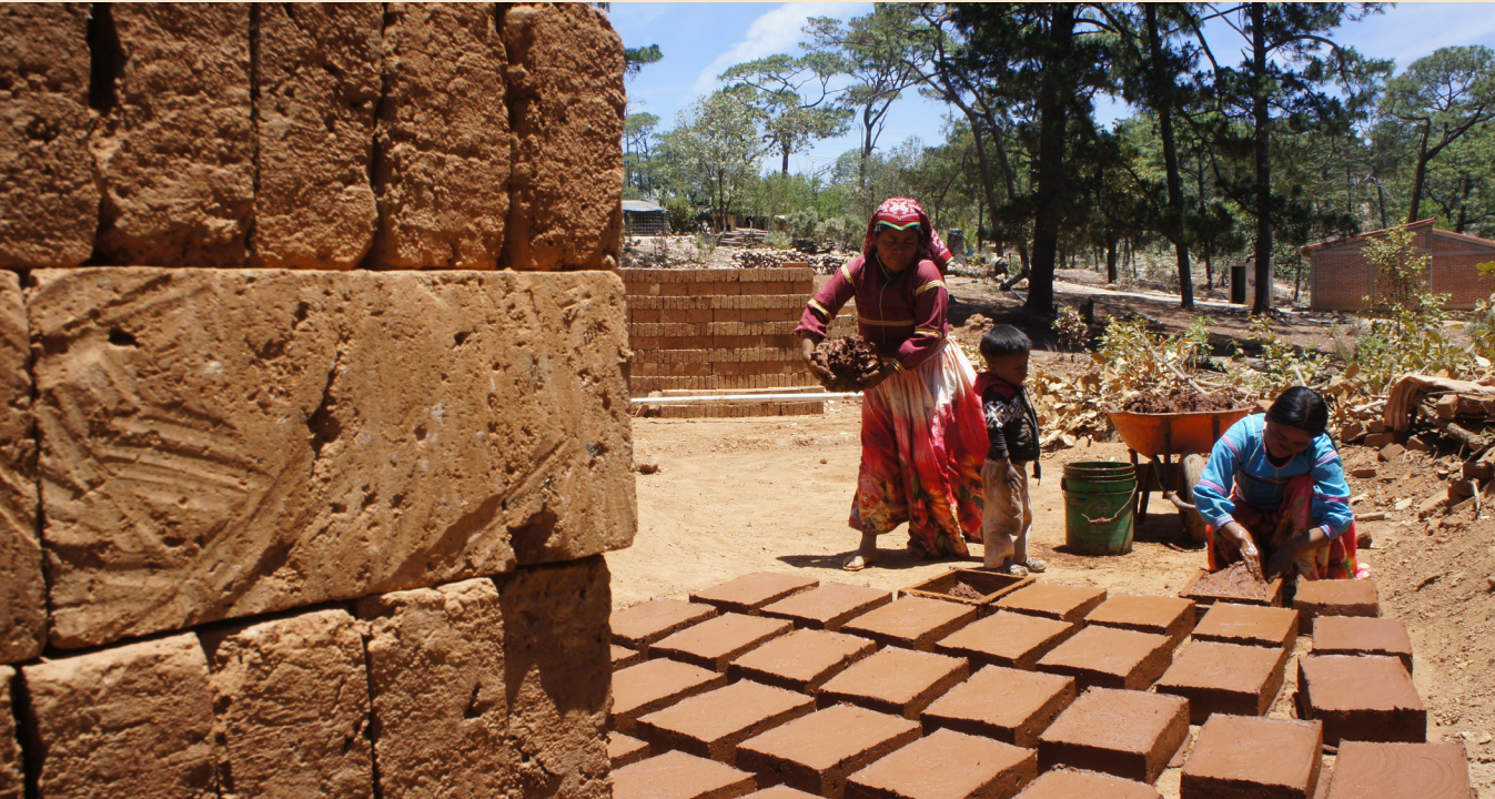
(2017). Zenaida y Amalia, mujeres wixárikas, fabricando los adobes para la construcción de su Centro Comunitario. Comunidad La Cebolleta, Sierra Wixárika de Jalisco, México.
